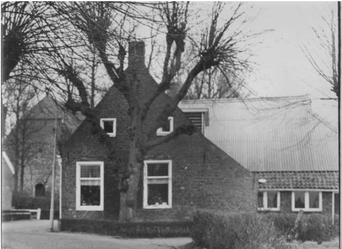
Woonhuis (Rudolf Agricolastraat) en achtergevel Laurentius kerk in Baflo.
